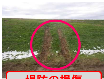
堤防の損傷
