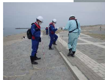
令和4年度の点検状況
