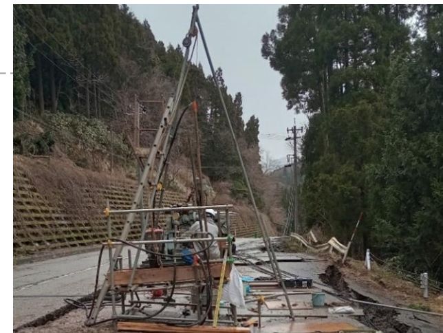
国道249号 中屋トンネル付近
