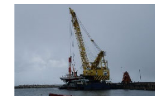
航路啓開の状況(2/27)
