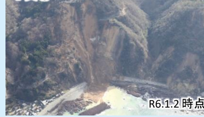
写真③ 国道249号法面崩落
