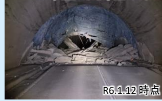
写真① 国道249号中屋トンネル
