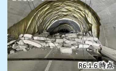
写真⑤ 国道249号大谷トンネル
