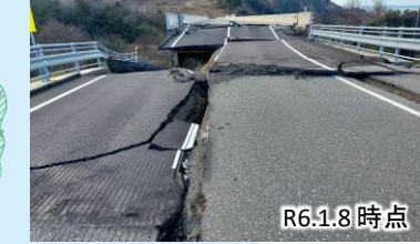
写真④ 国道249号烏川橋
