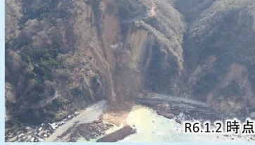
写真③ 国道249号法面崩落
