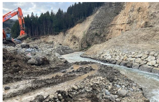
河道閉塞箇所 緊急工事
