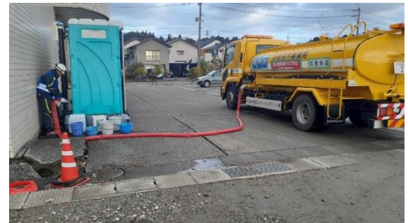
輪島市内 仮設トイレ約270基
