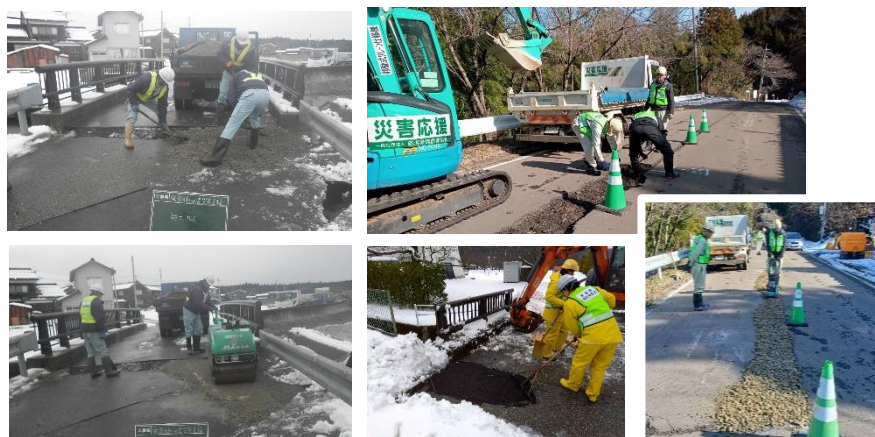
道路の段差解消作業
