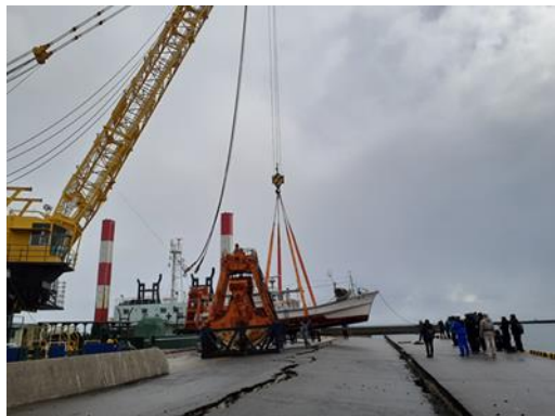
飯田港：泊地緊急復旧工事
