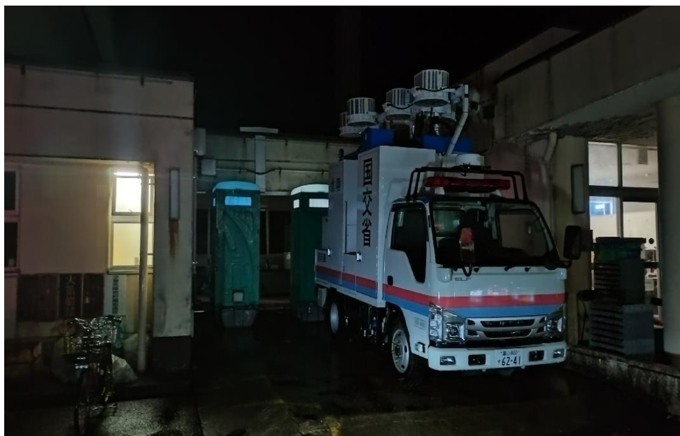
旧本小学校への電源供給
