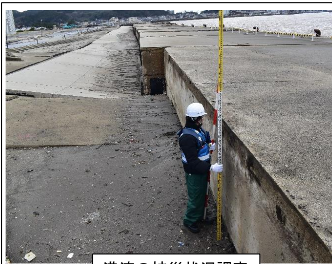
港湾の被災状況調査
