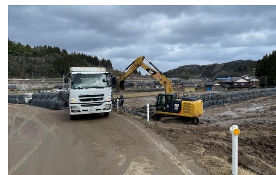
地すべり地区 緊急工事
