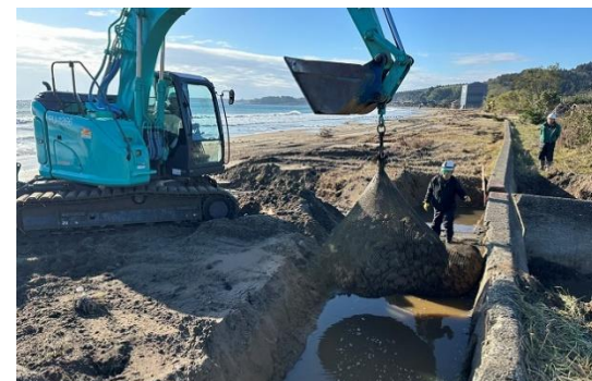
海岸施設 緊急工事
