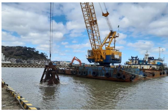
応急復旧工事の実施状況（船だまり啓開作業）
