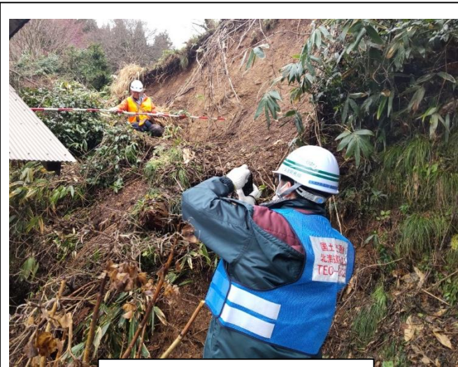
土砂災害の被災状況調査
