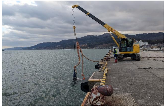
応急復旧工事の実施状況（水深7.5m岸壁） サンドポンプにより岸壁前面の土砂を除却
