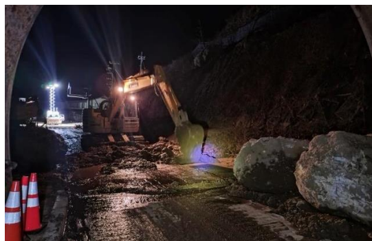
道路啓開 緊急工事
