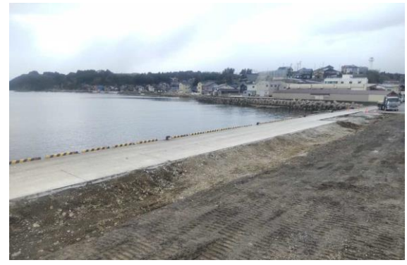
コンクリート版撤去完了（水深5m岸壁）
