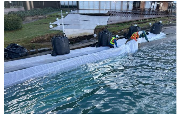
応急復旧工事の実施状況（和倉港海岸護岸）
