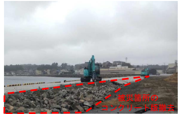
応急復旧工事の実施状況（水深5m岸壁）
