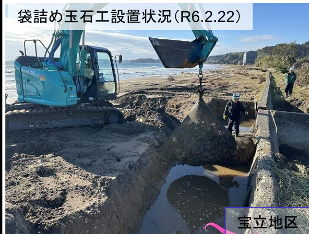
大型土嚢設置状況 (R6.2.26)
