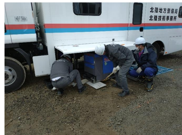
災害対策車両の現地整備 （（一社）日本建設機械施工協会（北陸支部））
