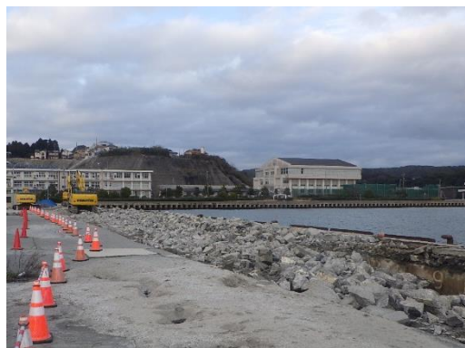
宇出津港：水深4m物揚場緊急復旧工事
