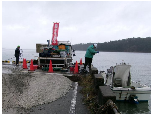
穴水港：被災状況の潜水調査
