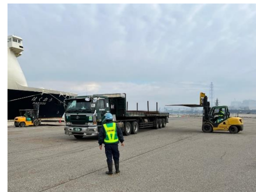
七尾港 大田地区：水深13m岸壁 緊急復旧工事
