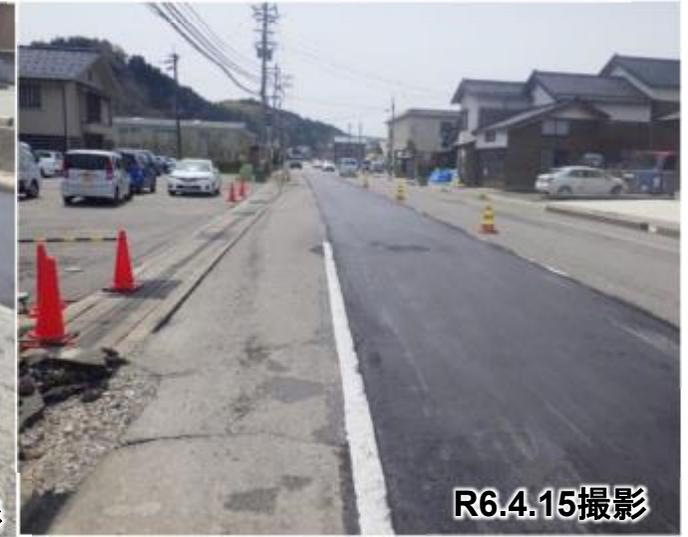
路面補修⑤の作業状況(段差擦付け)
