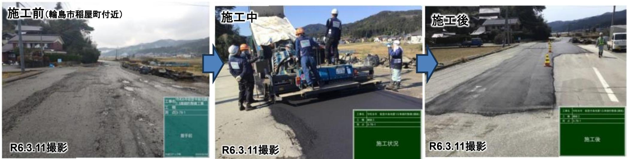
●輪島市大野町から輪島市長井町までの区間 路面補修・拡幅工事の状況
