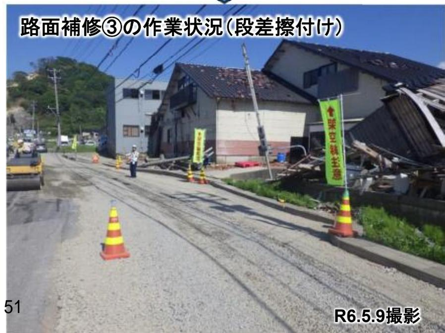
●輪島市大野町から輪島市長井町までの区間 路面補修・拡幅工事の状況
