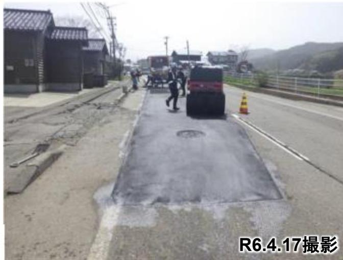
路面補修⑤(消火栓隠蔽部コア削孔)
