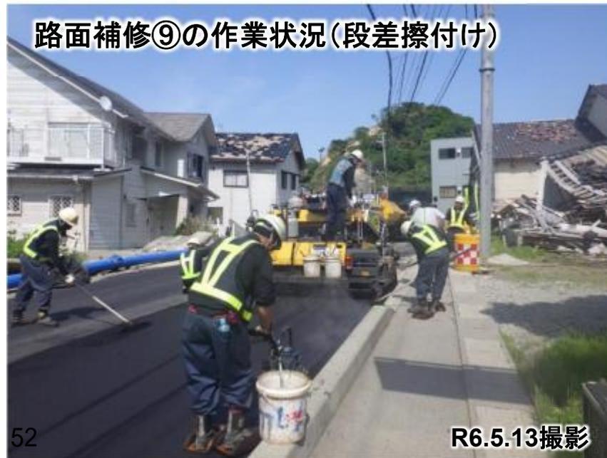
路面補修⑨の作業状況(段差擦り付け)
