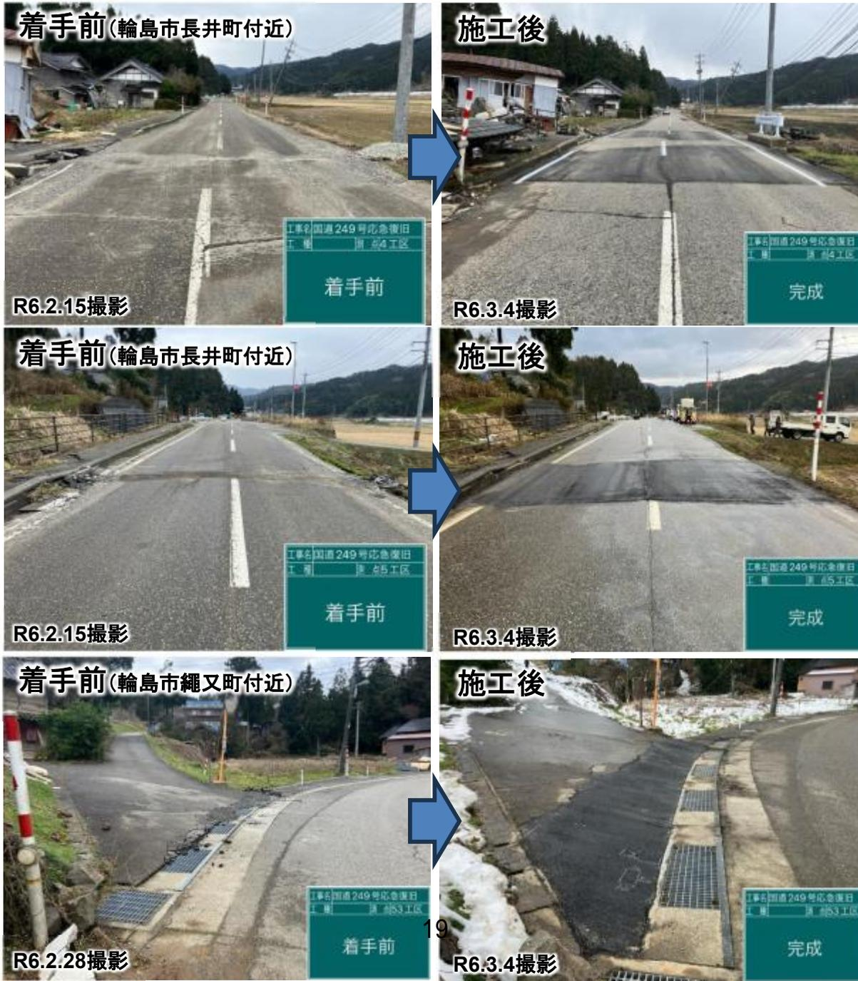
● 輪島市長井町～輪島市門前町西円山までの区間 路面補修・拡幅工事の状況
