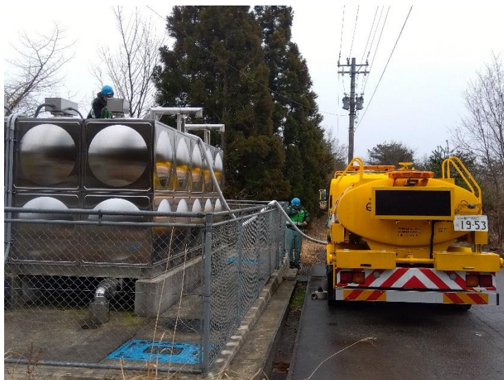
給水状況(能登町内)
