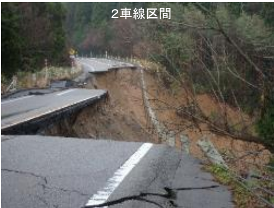
4車線／2車線区間の崩壊事例
