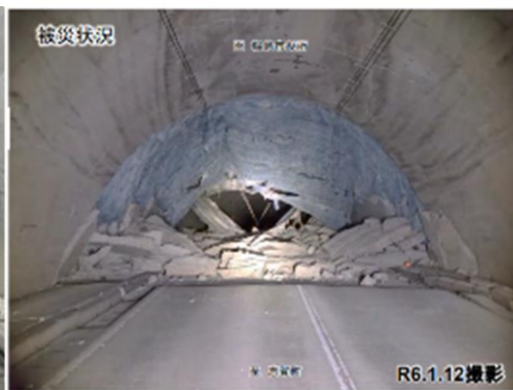
中屋トンネル(国道249号)
