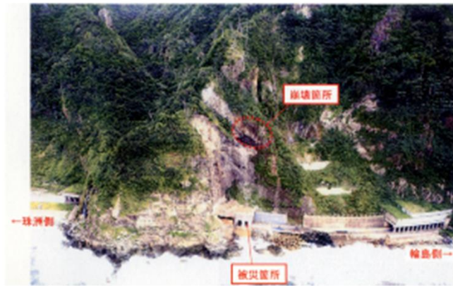
写真-2.3.25 被災箇所の被災前全景(毎日航空資料より)
