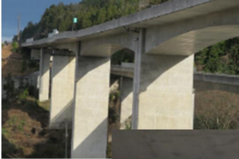
穴水道路 穴水高架橋(H14道示)
