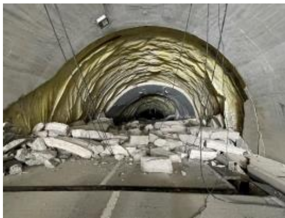
大谷トンネル(国道249号)
