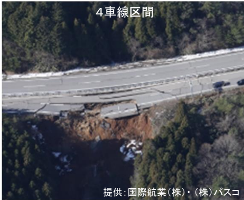
4車線／2車線区間の崩壊事例
