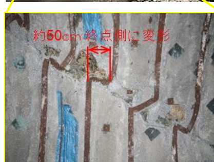
写真1. 大谷トンネル覆工崩落・変形 写真2. 中屋トンネル覆工崩落
