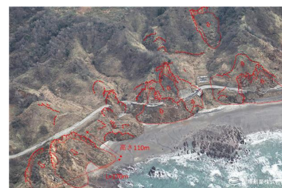
写真5. 大川地区の地すべり・斜面崩壊
