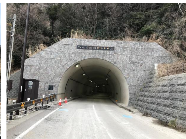
輪島側坑口；変状なし
