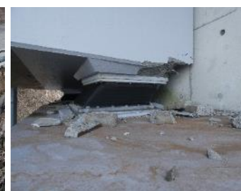
写真1. 大谷トンネル覆工崩落・変形 写真2. 中屋トンネル覆工崩落
