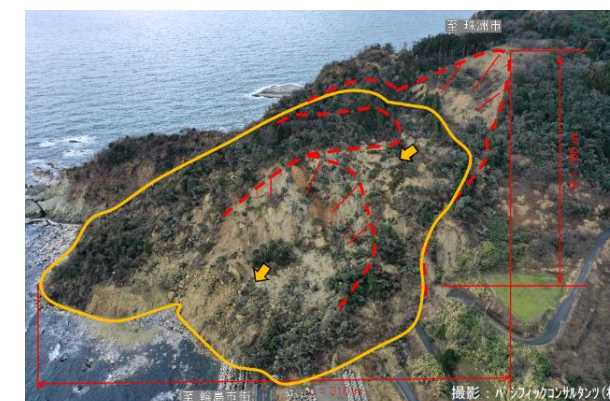
写真7. 逢坂トンネル輪島側坑口閉塞
