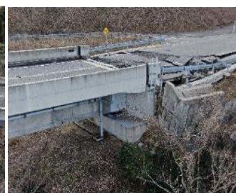
写真3. 鳥川大橋の損傷
