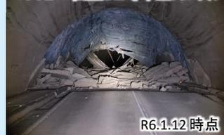
写真③ 国道249号法面崩落
