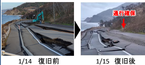
写真② 国道249号緊急復旧完了
