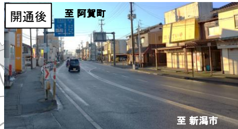
開通後の通勤時間帯の状況 [R5. 12. 4撮影]
