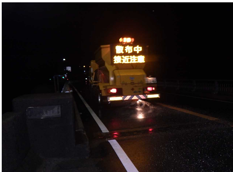
かにでら 国道41号富山市蟹寺における作業状況
