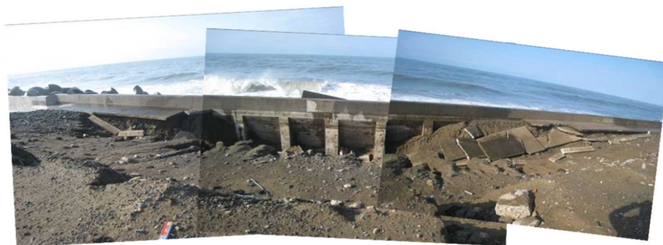
海岸堤防被災のイメージ（平成22年1月 冬季風浪による小松地区の被災事例）
