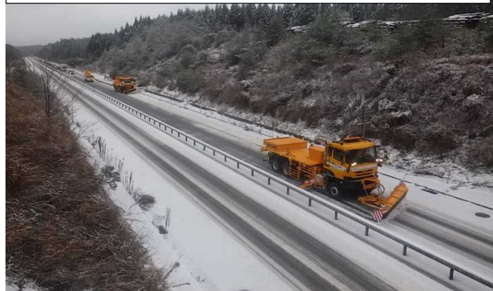
能越自動車道 穴水道路 除雪状況 令和4年12月
