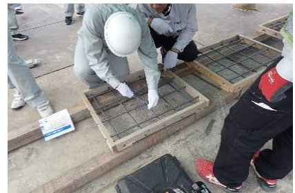
鉄筋組立体験(他現場での事例)
