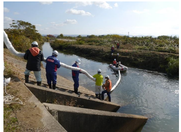
オイルフェンスの展張
