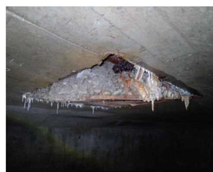
橋の裏面の様子
