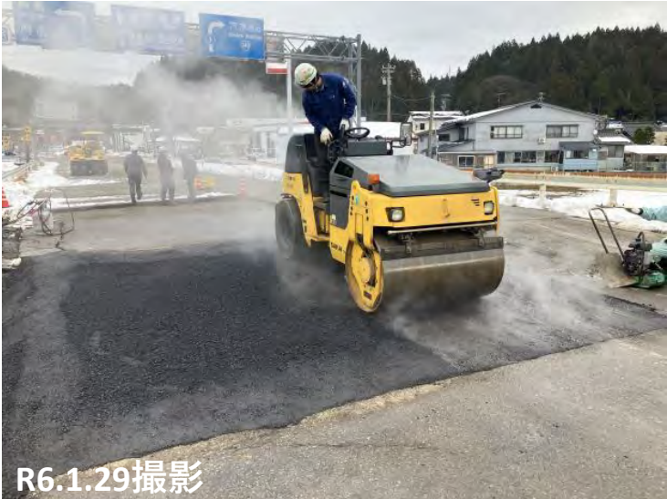
No41～42 舗装状況
