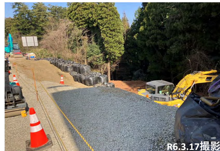
No.37大型土嚢設置、碎石投入状況
