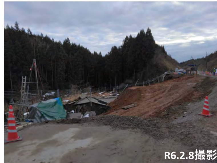
No.16 GR集積・がら撤去状況
