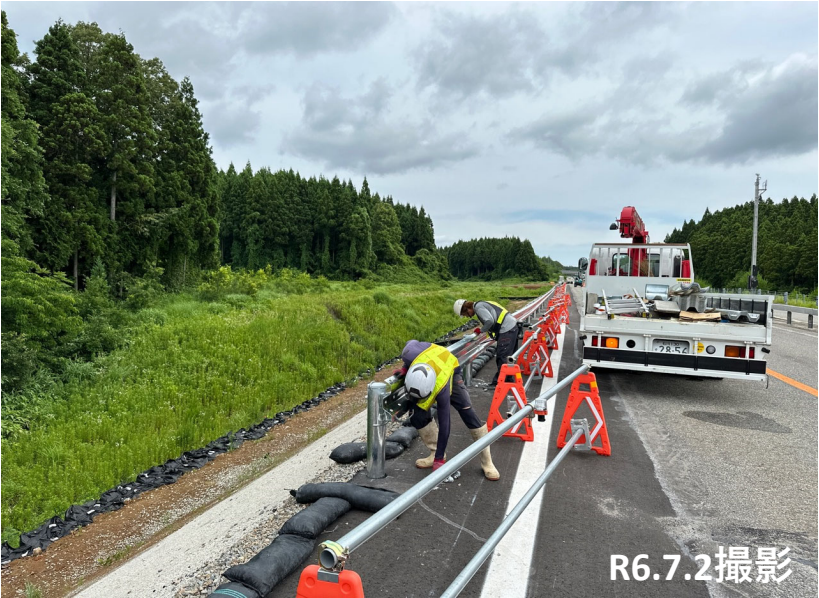
No.16付近 ポストコーン設置状況
