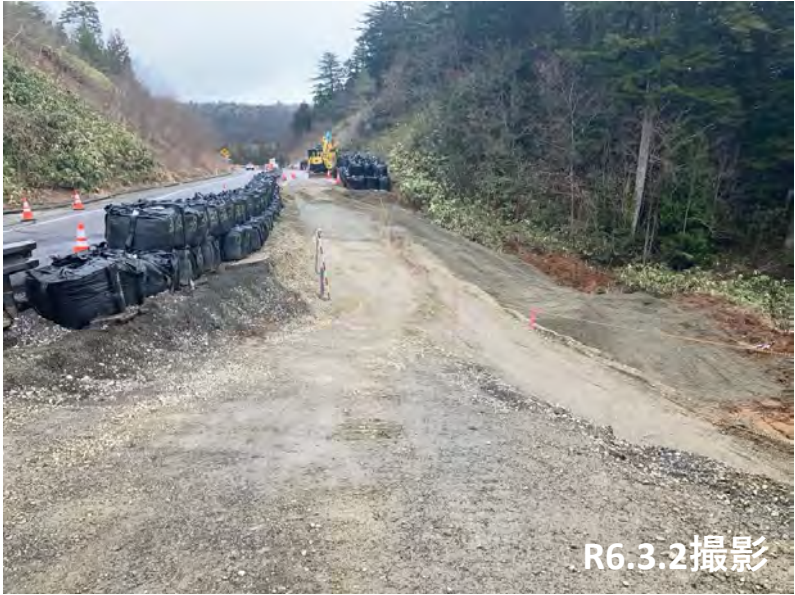
No.44付近 路盤不陸整正転圧状況
