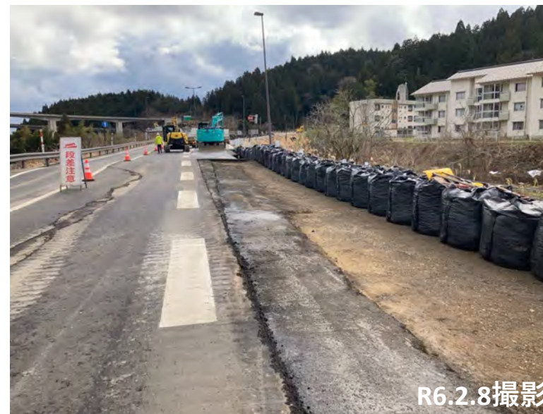
No.42付近 大型土嚢設置状況
