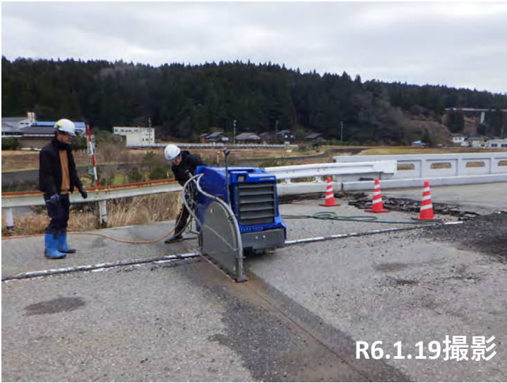
No.6 段差復旧状況
