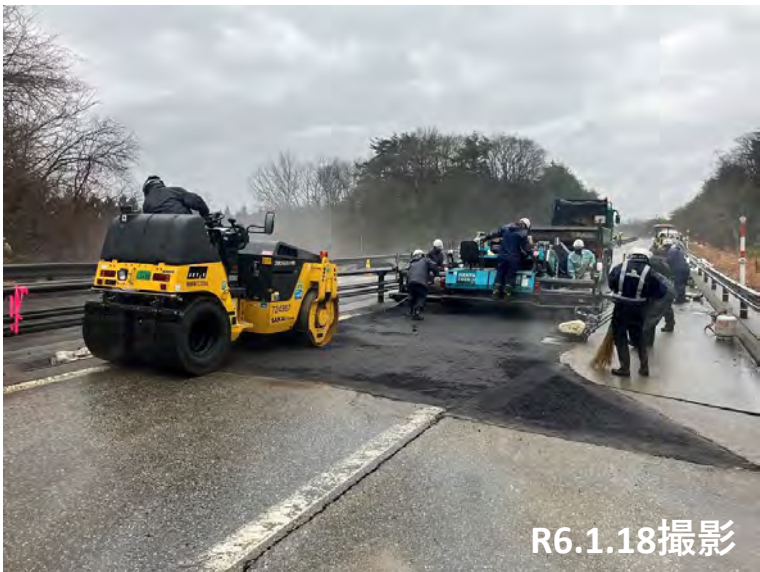
No.6 段差復旧状況
