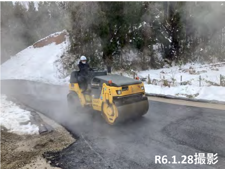
No17～29 舗装状況
