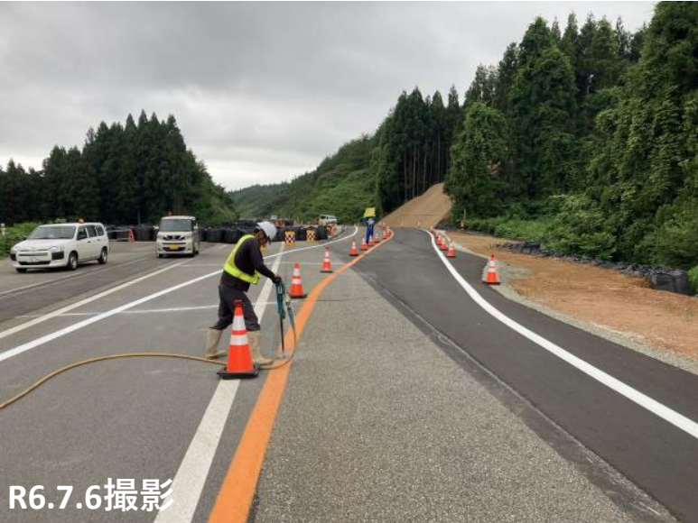
No.16付近 ポストコーン設置状況
