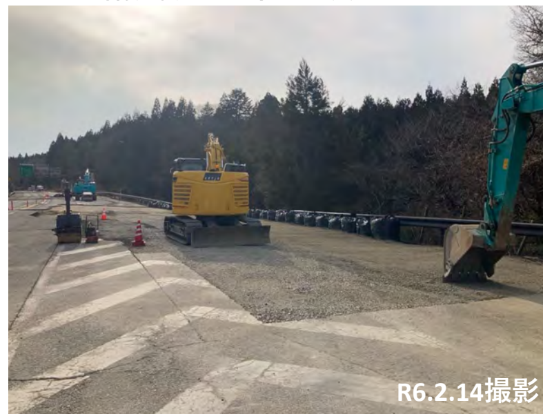
No.56 舗装撤去・砕石埋戻し
