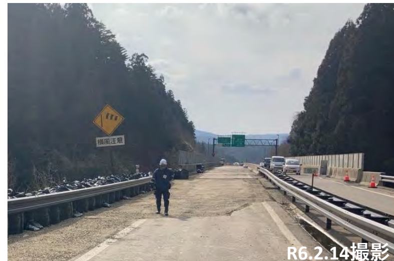
No.40 砕石敷均し状況
