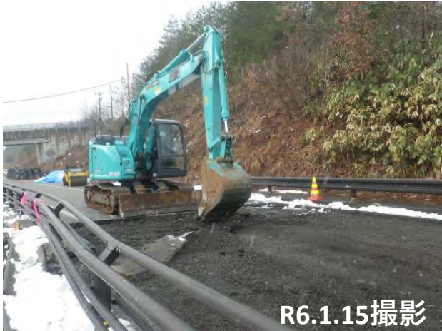
No.6段差復旧状況
