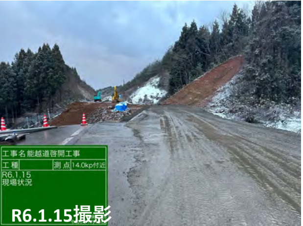
No.16 法面切土
