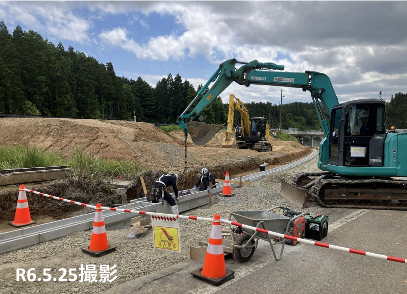
No.44付近 側溝設置状況
