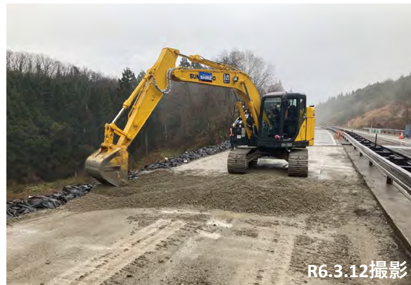
No.51付近 崩落箇所埋戻し状況
