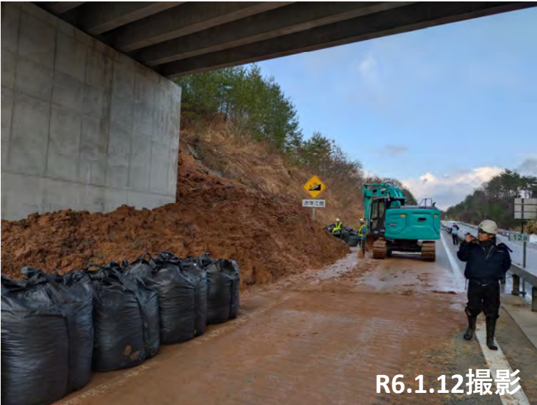
No.6 掘削・土嚢設置状況
