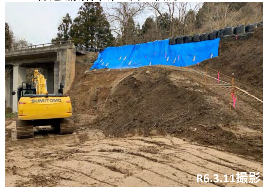
No.51付近 崩落箇所埋戻し状況
