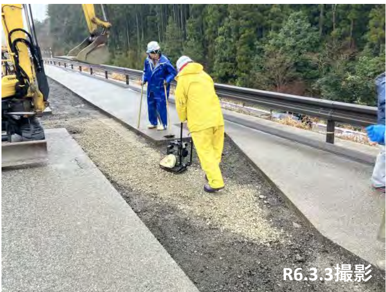
No.44付近 路盤不陸整正転圧状況
