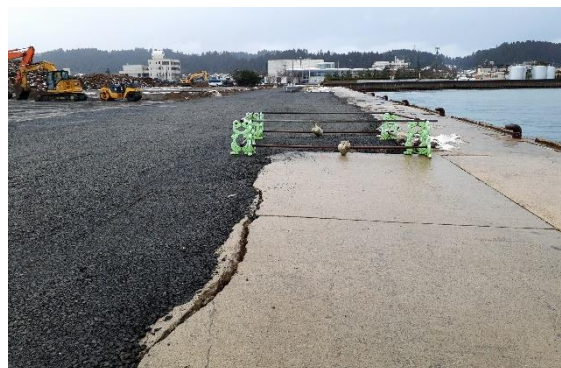
応急復旧後の状況（水深4.5m岸壁）
