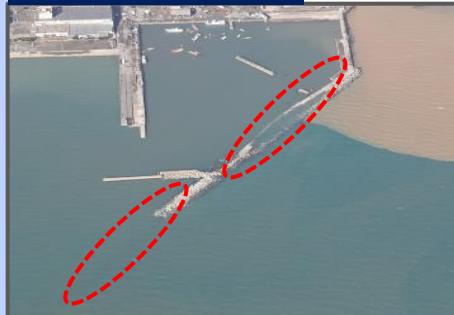
防波堤の破壊
