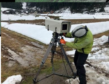
監視カメラ・Ku-SAT(衛星通信装置)設置状況 (紅葉川)
