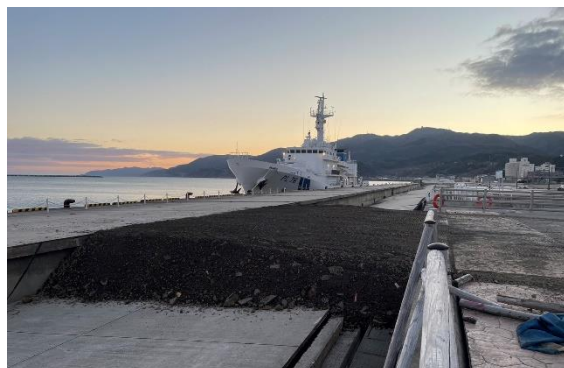
応急復旧後の状況（水深7.5m岸壁）
