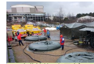
東北地整（七尾市） （自衛隊入浴施設給水）
