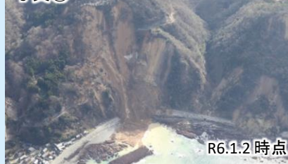
写真④ 国道249号法面崩落
