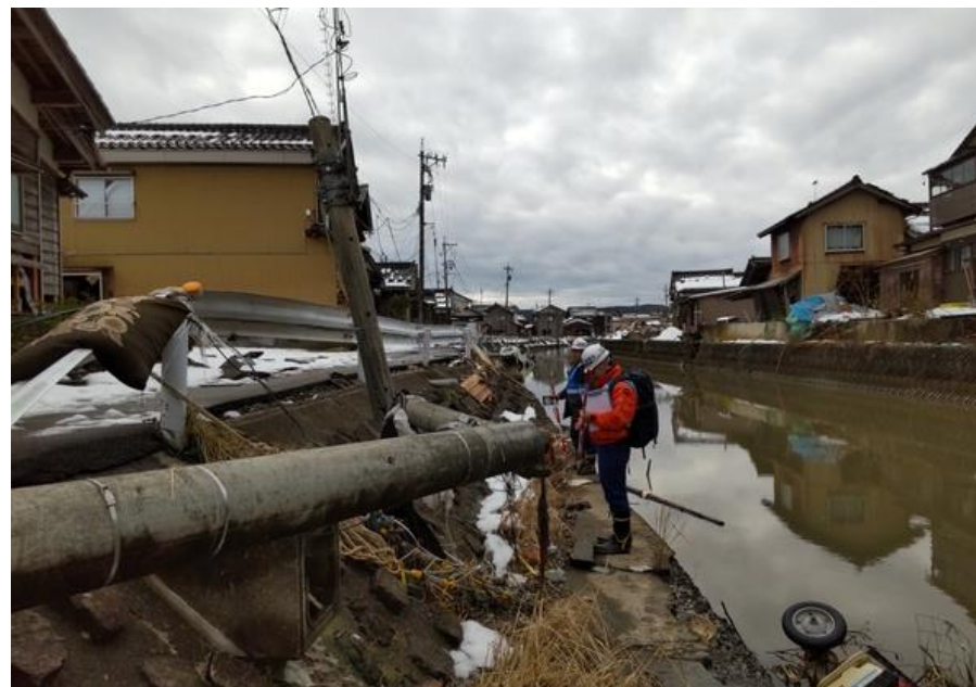
津波遡上調査(珠洲市_磐若川)
