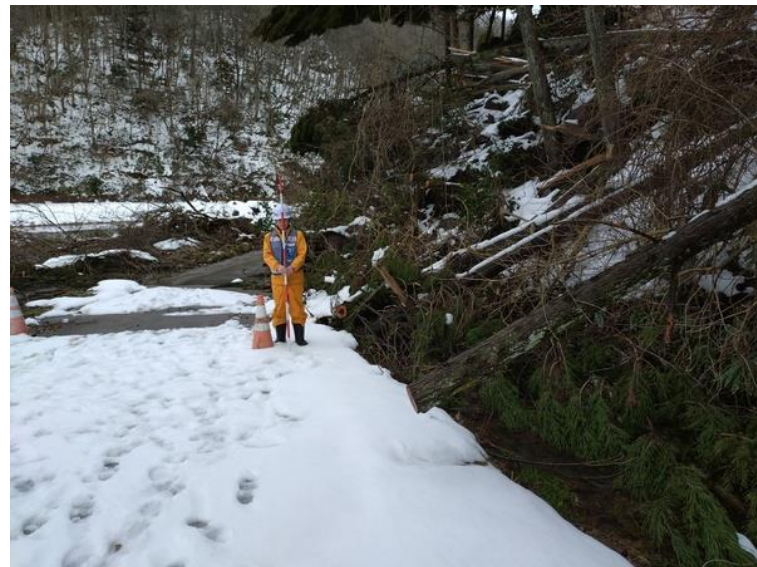
第2班 能登町 被災状況調査
