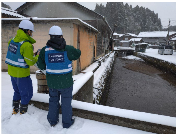
第3班 穴水町 護岸被災状況調査
