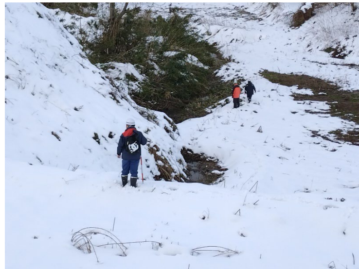
第2班 志賀町 被災状況調査
