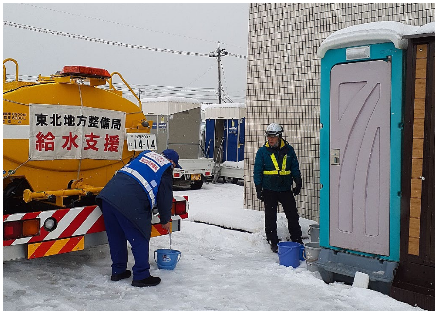
珠洲商工会議所への給水支援状況
