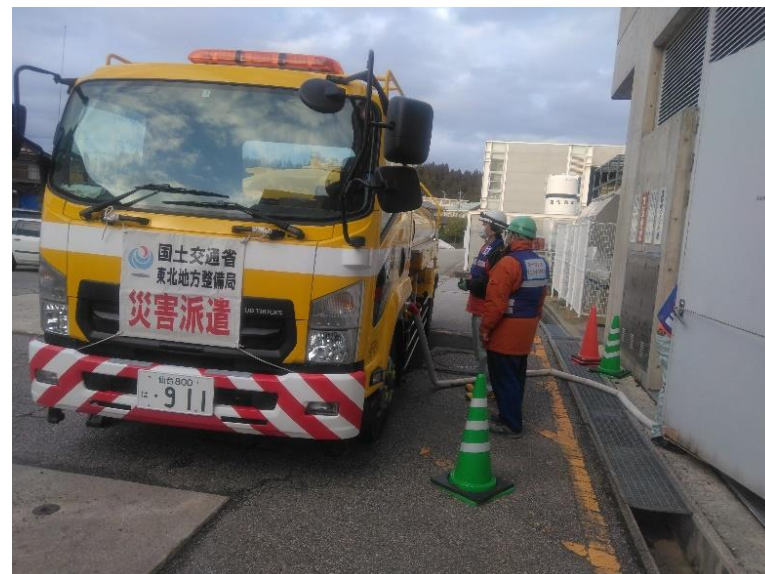
珠洲市総合病院への給水支援状況
