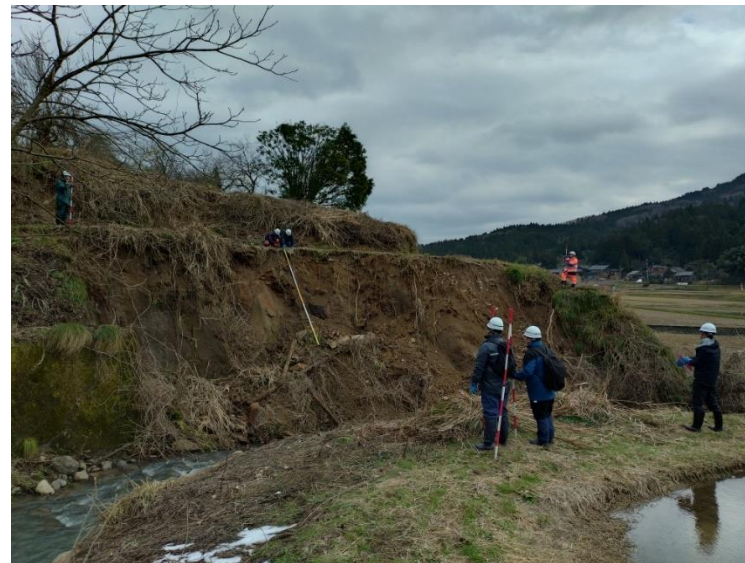
第6班 輪島市 河岸被災状況調査
