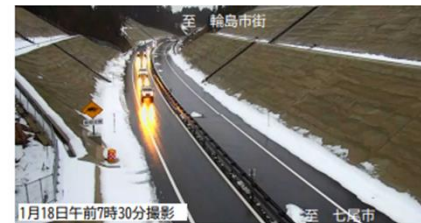
■写真① 輪島市三井町小泉高架橋付近
