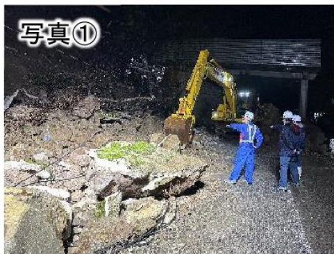
写真① 県道1号 輪島市三井町での啓開作業(1月3日撮影)
