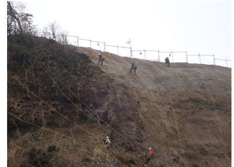
法面上部の金網設置作業【1/18(木)10時撮影】
