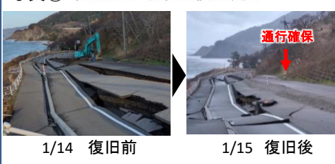
写真③ 国道249号緊急復旧完了
