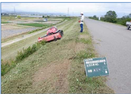
地域住民による堤防除草 （大型除草機械）
