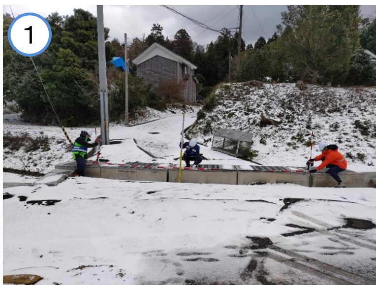
被災状況調査（輪島市杉平町）
