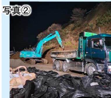
国道249号作業状況
