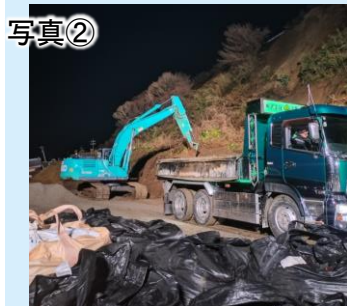
国道249号作業状況
