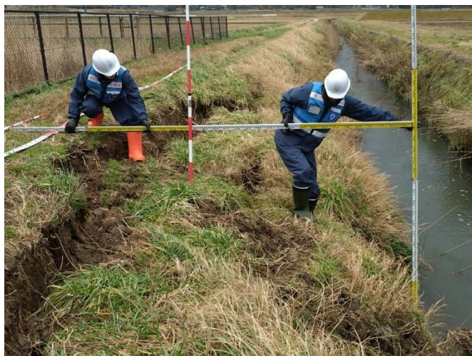
第3班 志賀町被災状況調査
