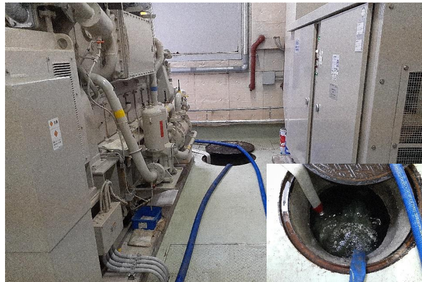
地下貯水タンクに水を給水
