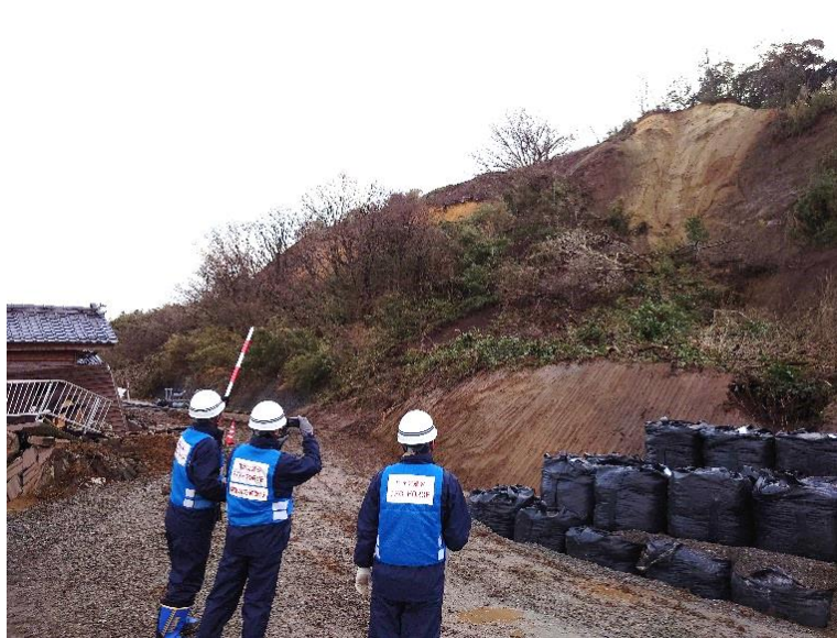
被害状況調査(石川県輪島市大野町)
