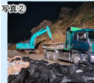
国道249号作業状況
