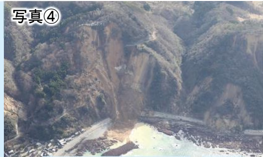
国道249号法面崩落
