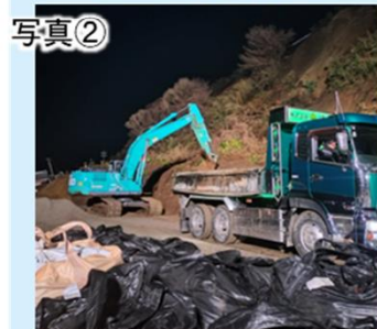
国道249号作業状況
