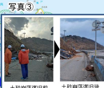
土砂崩落復旧前 土砂崩落復旧後
