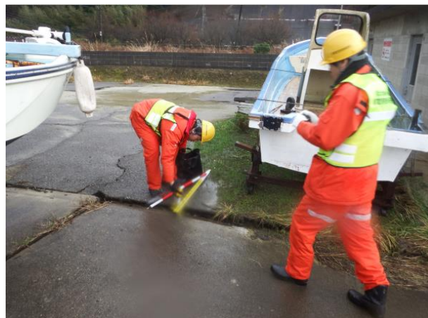
七尾港 被災状況調査
