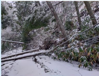
県道38号被害状況
