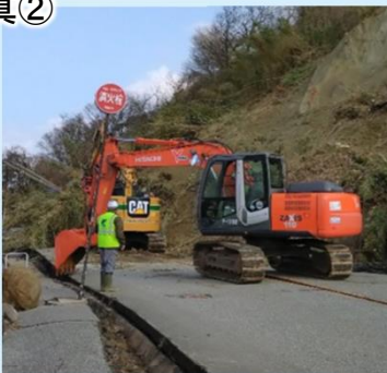
国道249号作業状況
