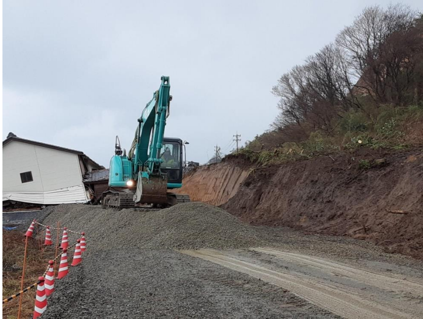
国道249号輪島市稲舟町付近
