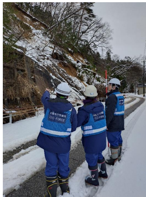
土砂崩落箇所調査状況 4(珠洲市若山町出田地先)
