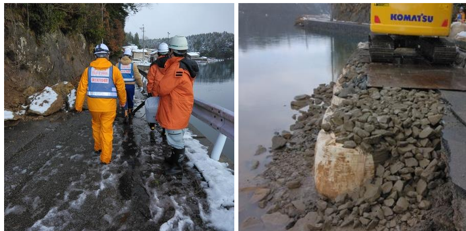
【市町道調査班】穴水町内の道路状況を確認
