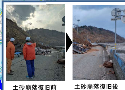
土砂崩落復旧前 土砂崩落復旧後
