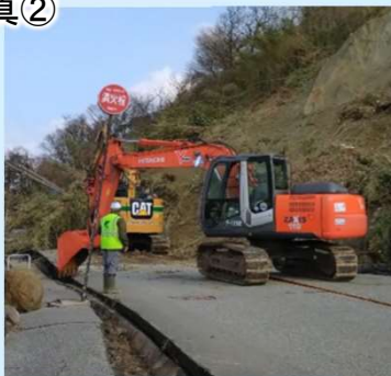
国道249号作業状況
