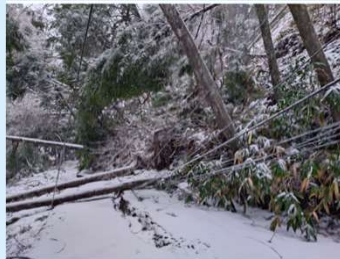
県道38号被害状況
