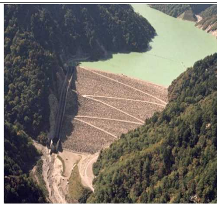
高瀬ダム (東京電力リニューアブルパワー(株))
