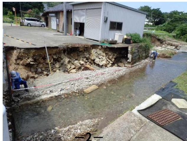
河川護岸の損傷を調査
