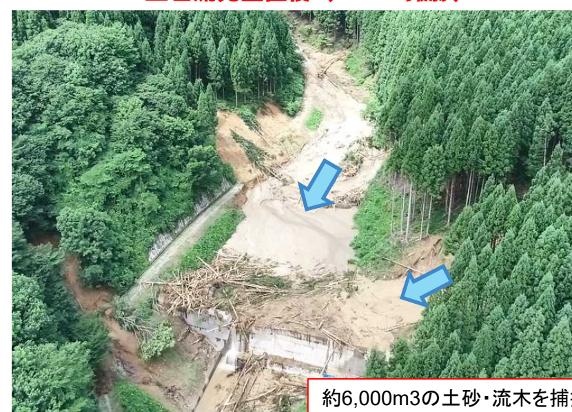
土石流発生直後 (R4.8.4撮影)
