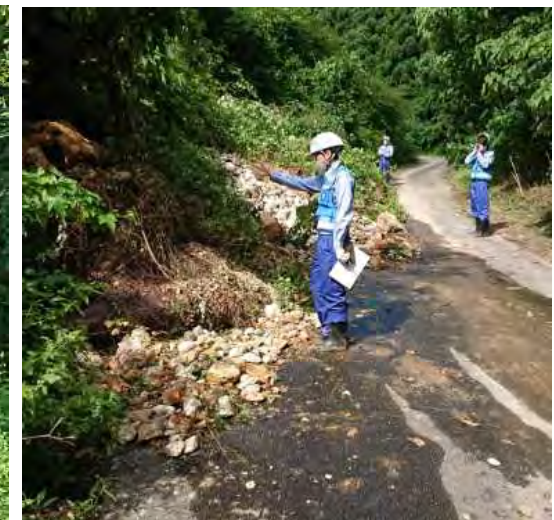
② 大石地区の崩落箇所
