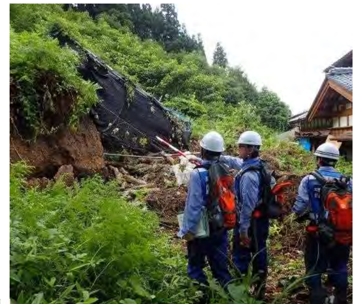
②内須川斜面崩落状況確認
