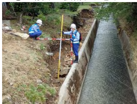
①-2 護岸の損傷状況を確認
