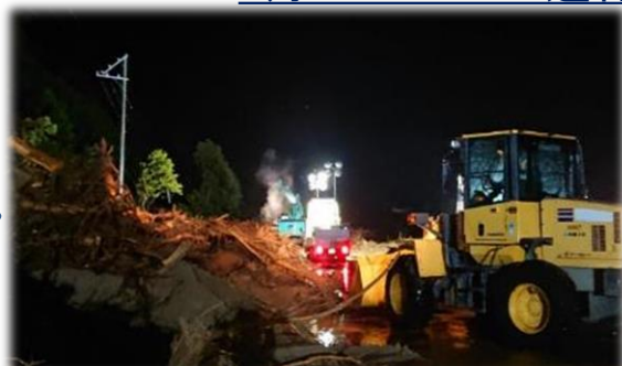
【道路啓開作業状況】 (8月4日～)夜間も継続して啓開作業を実施。
