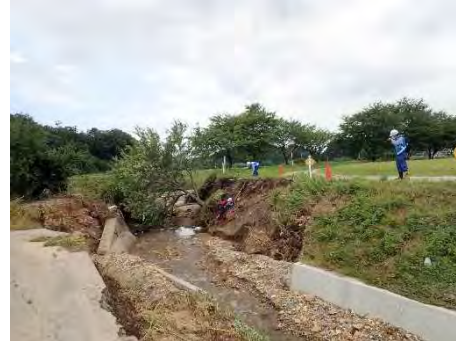
①-1 護岸の損傷状況を確認
