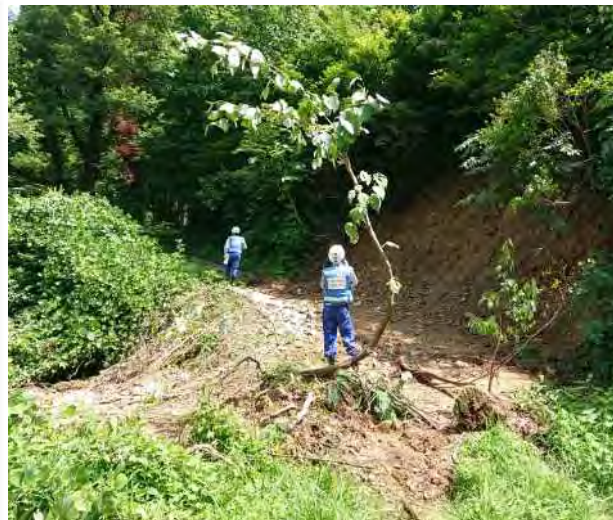
① 金丸地区の崩落箇所
