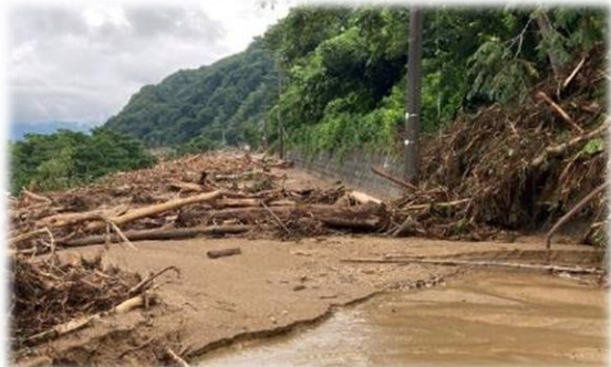
【道路啓開作業着手】(8月4日 6時50分～)
