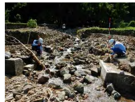
④ 護岸の損傷状況を確認
