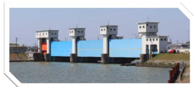
<写真：上段_新潟大堰、下段_信濃川水門>
