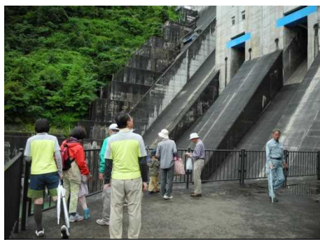
ダム内部見学
