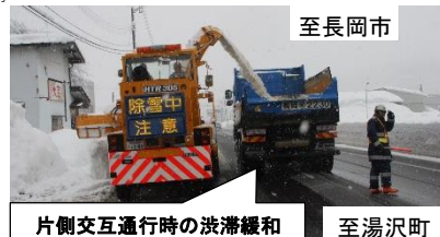
現道区間における運搬排雪作業状況 (令和4年1月)
