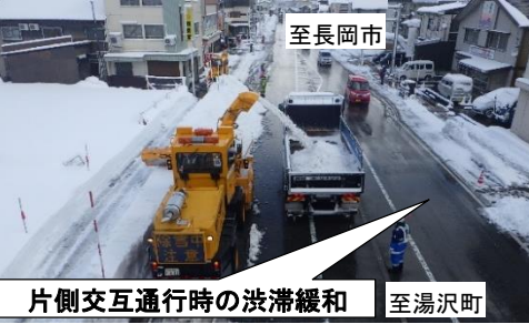
現道区間における運搬排雪作業状況 [令和4年1月14日]
