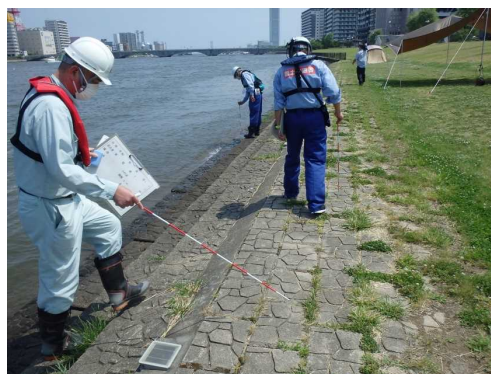
点検の状況(信濃川:新潟県)
