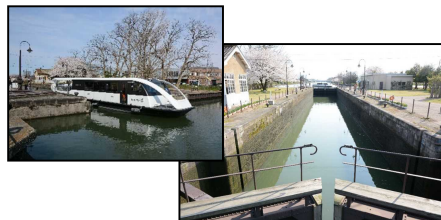
富岩水上ラインと中島閘門
