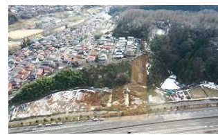
◆道路外からの土砂流入
