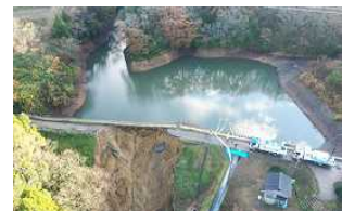
◆ため池緊急排水作業
